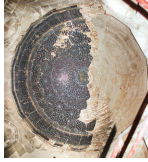
Şekil 4. Eşrefoğlu Türbesi Kubbesi restorasyondan önce
