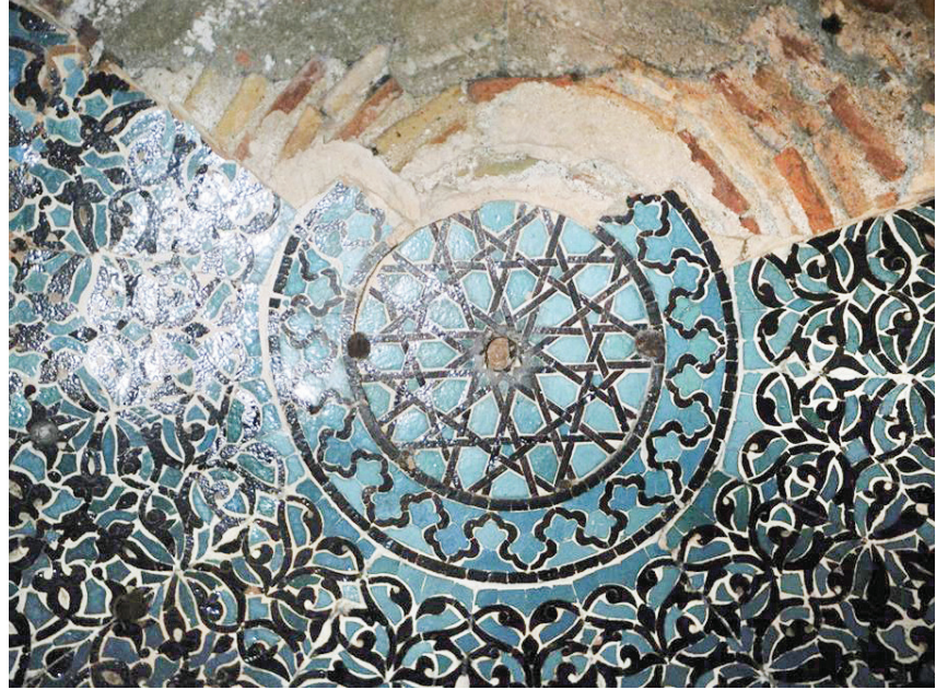
Şekil 19. Kubbede mozaik çini blokların demir çivi ile sabitlenmesi
