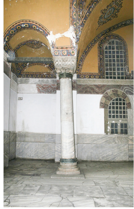
Şekil 30. Üst galerideki Marmara mermerinden yapılmış taşıyıcı sütunda deprem etkisiyle oluşan eğilme. (Fotograf: Serkan Angı).
