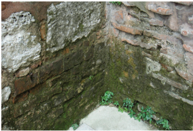
Şekil 26. Küfeki taşı ve tuğlalarda görülen yosunlaşma ve bitki oluşumu (Fotograf: S. Angi).
