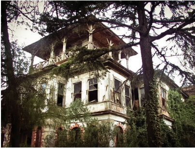
İzmit Selim Sırrı Paşa Konağı, restorasyondan önce
