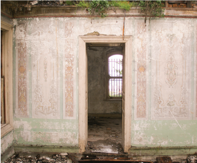
Konağın iç mekânından görünüm, restorasyondan önce
