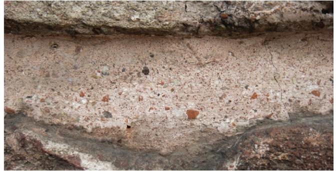
Şekil 10. Duvarda kullanılan harç malzemesinin görünümü (Fotoğraf: S. Angi).
