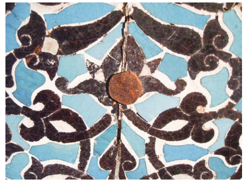
Şekil 18. Mozaik çini blokların demir çivi ile sabitlenmesi
