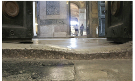
Şekil 28. Kapı eşiğindeki Marmara mermerinde insan trafiğine bağlı olarak oluşan aşınma (Fotograf: S. Angi).
