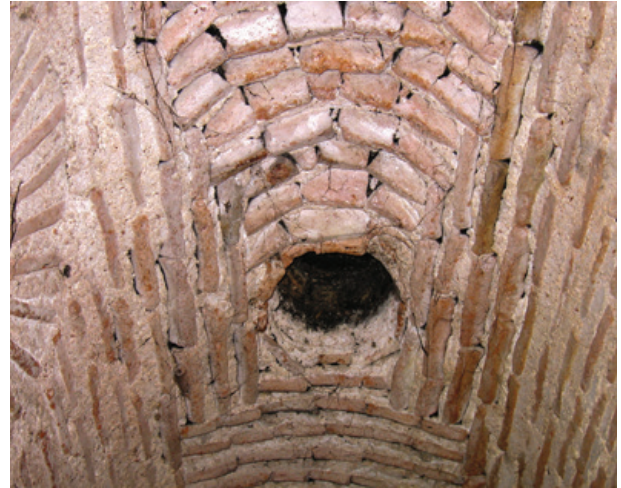
Şekil 25. Hoca Hamza Mescidi Altındaki Sarnıcı'ta su çekme menfezinin görünümü (F. Özgümüş Arşivi)
