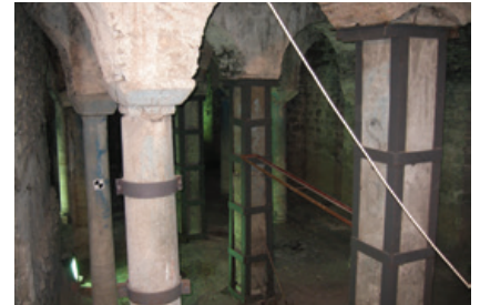
Şekil 14. Nakilbent Sokağı Sarnıcı ve Vefa Kilise Camii'nin Batısındaki Sarnıç'ta taşıyıcılar.
