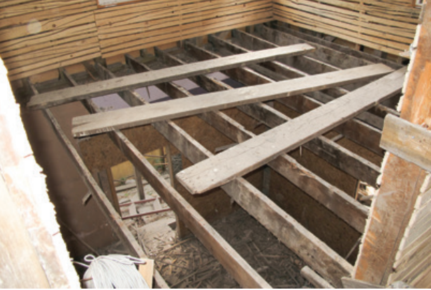
Şekil 21. Yerinde korunan özgün döşeme kirisleri.
