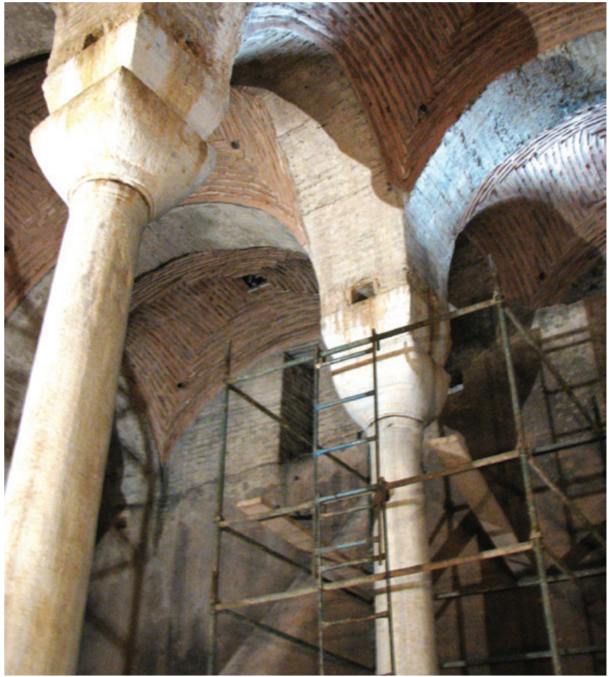
Şekil 21. Zeyrek (Pantokrator) Sarnıcı'nda kemer üzengi hizasında gergi kirişi yuvaları.
