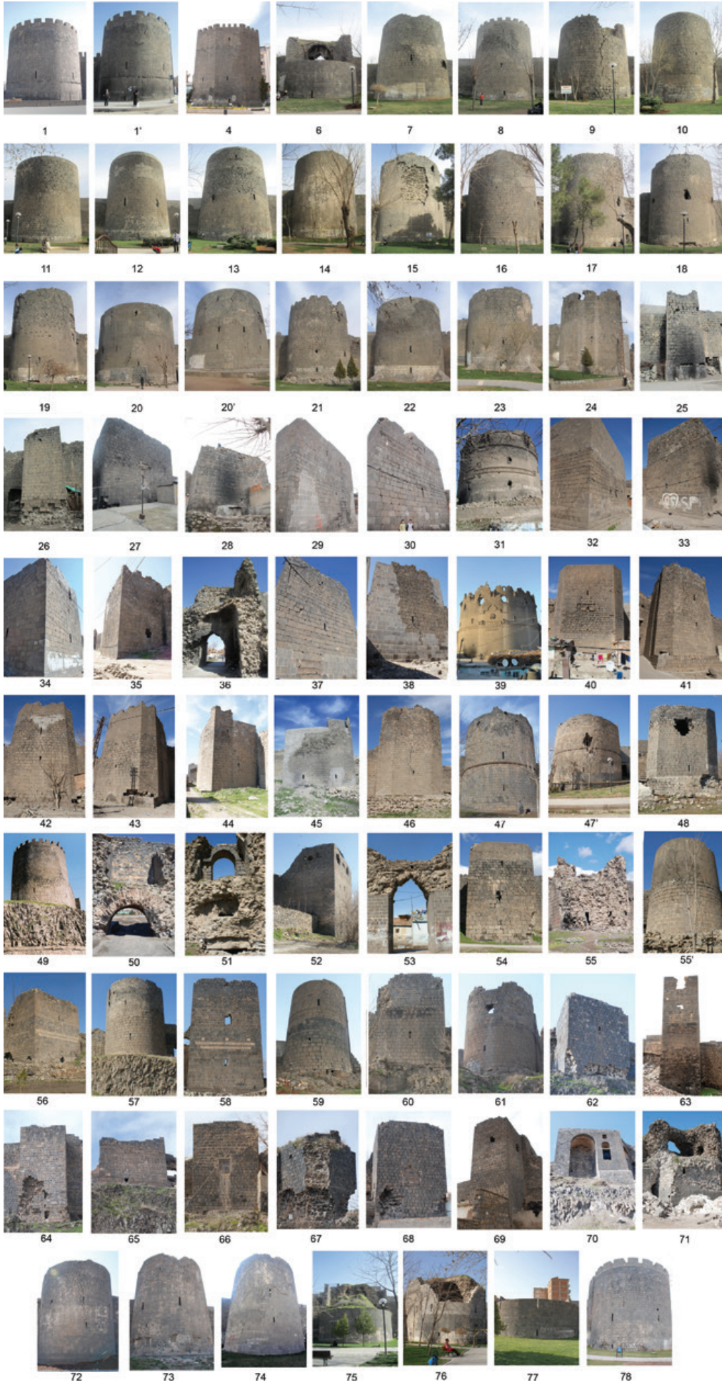
Şekil 7. Dış Kale burçlarının (1-78 no.lu burçlar) sur dışından görünüşleri.
