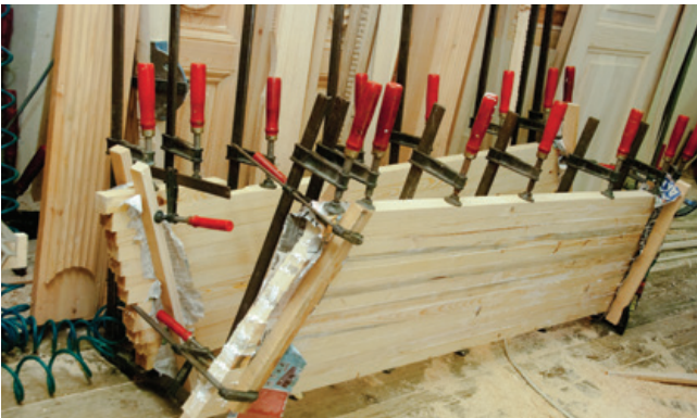
Şekil 33. Basamakların yapımı ve montajı.
