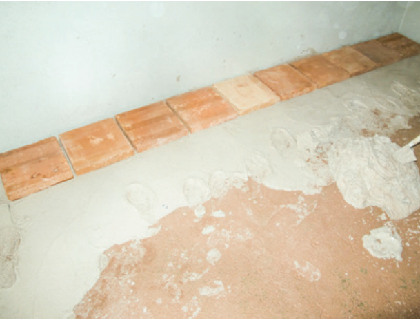
Şekil 27. Bodrum katta tuğla döşeme yapımı.
