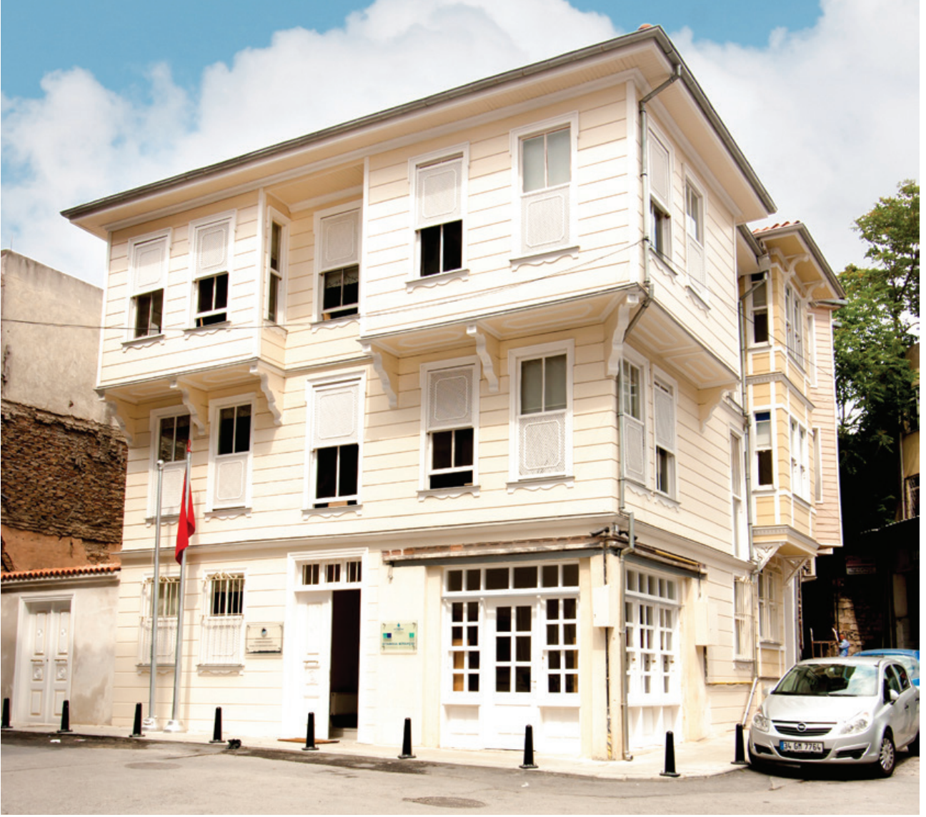
Şekil 53. Yapının onarım sonrası görünümü.
