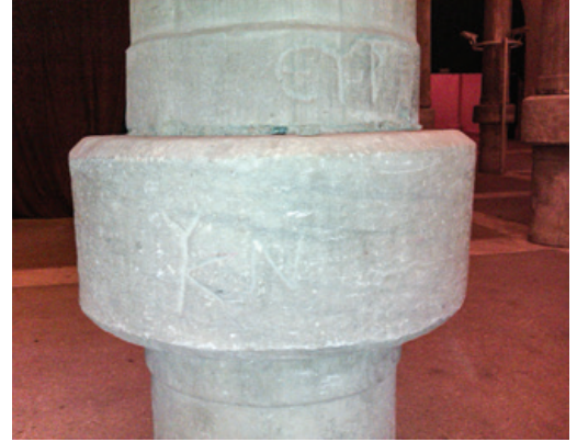
Şekil 13. Binbirdirek (Philoksenos?) Sarnıcı'nda iki parçalı sütun uygulaması.
