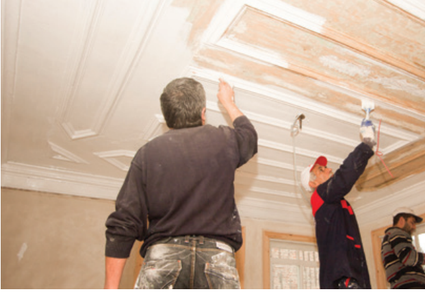
Şekil 48. İç mekânda boya uygulaması.
