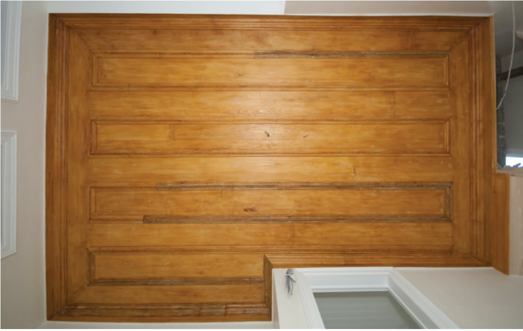
Şekil 46. 1K01/A tavanında gomalak cilâ uygulaması
