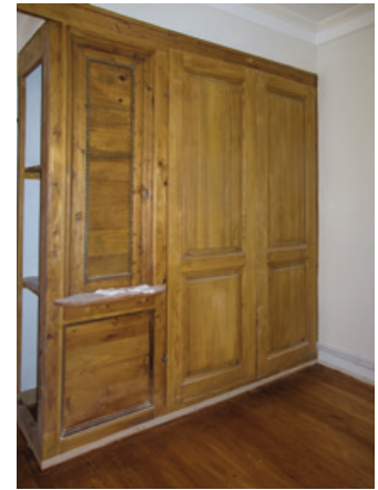
Şekil 43. Ahşap koruyucu uygulamadan sonra yüklüğün görünümü.
