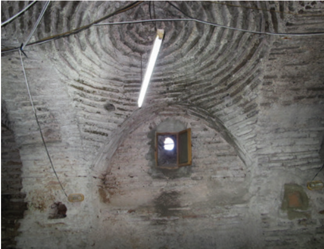
Şekil 24. İbadethane Sokağı II no.lu Sarnıcı'ta havalandırma penceresi
