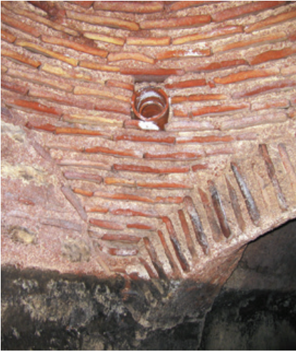
Şekil 26. Bible House Sarnıcı (F. Özgümüş Arşivi) ile Kirazlı Mescit Sarnıcı'na su sağlayan künk kalıntıları.
