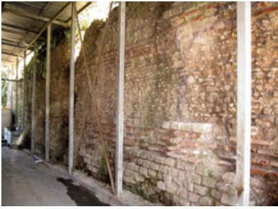
Şekil 8. Açık sarnıçlardan Aetius, Aspar ve Mokios (Altmermer) Sarnıçlarında duvar örgü sistemleri.
