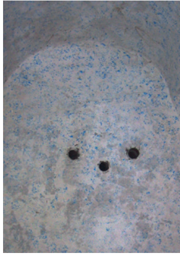
Şekil 26. Bible House Sarnıcı (F. Özgümüş Arşivi) ile Kirazlı Mescit Sarnıcı'na su sağlayan künk kalıntıları.
