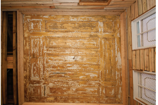
Şekil 11. 2K02 tavanında yerinde koruma.
