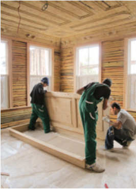
Şekil 39. Kapıların montajı.
