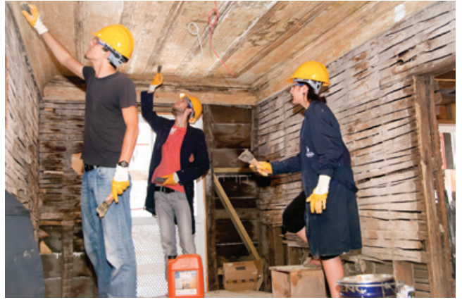
Şekil 10. Kimyasal yöntemle boya söküm işlemi.
