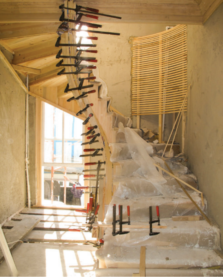
Şekil 36. Kúpestenin yapımı.
