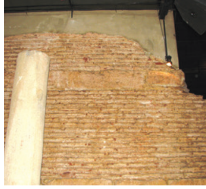
Şekil 9. İbadethane Sokağı I no.lu Sarnıç, Antik Otel Sarnıcı ve Sultan Sarnıcı'nda duvar örgü sistemi detay görüntüleri.
