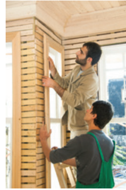
Şekil 40. Pervazların montajı.
