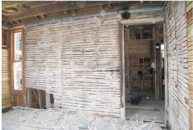
Şekil 2. Özgün "yarma bağdadî duvar" yapım tekniği.
