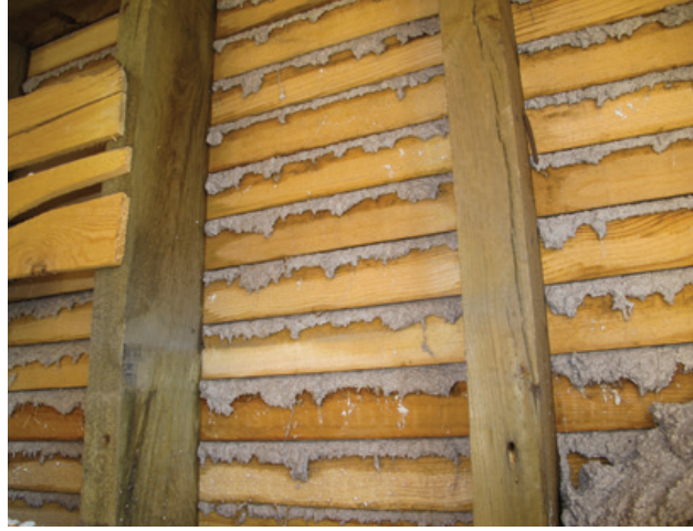
Şekil 44. Bağdadî duvarda sıvanın ahşap çitalara tutunması.
