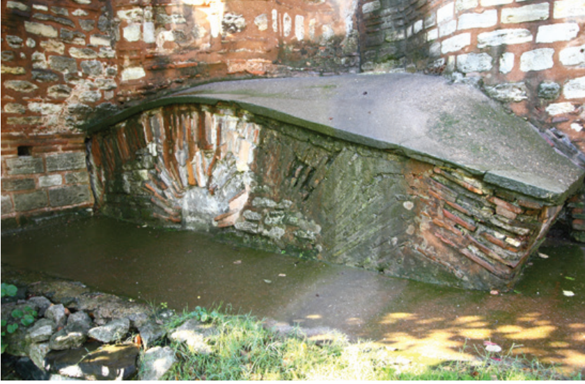
Portland çimento bağlayıcılı dolgu örtü sistemi.
