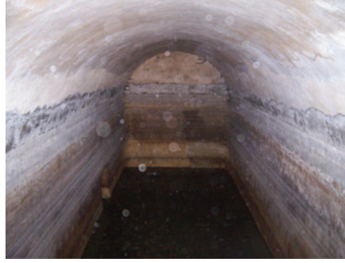
Şekil 22. İmaret Sabunhanesi Sokağı Sarnıcı'nda (Koruma Kurulu Arşivi) ve Kupağası Mahmut Ağa Camii Altındaki Sarnıcı'ta (F. Özgümüş Arşivi) beşik tonozlu örtü sistemi.
