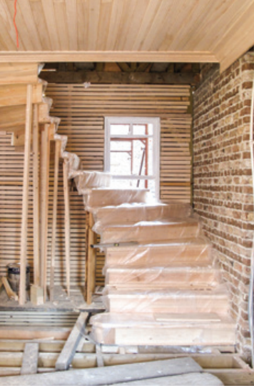
Şekil 34. Merdivenin yapımı (dönem eki yapı).
