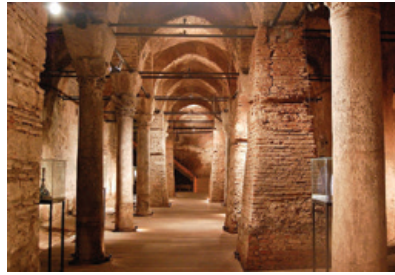
Şekil 14. Nakilbent Sokağı Sarnıcı ve Vefa Kilise Camii'nin Batısındaki Sarnıç'ta taşıyıcılar.
