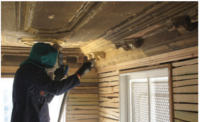
Şekil 12. Mikro kumlama ile boya söküm işlemi.
