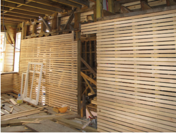
Şekil 6. Çakma bağdadı duvar yapımı.
