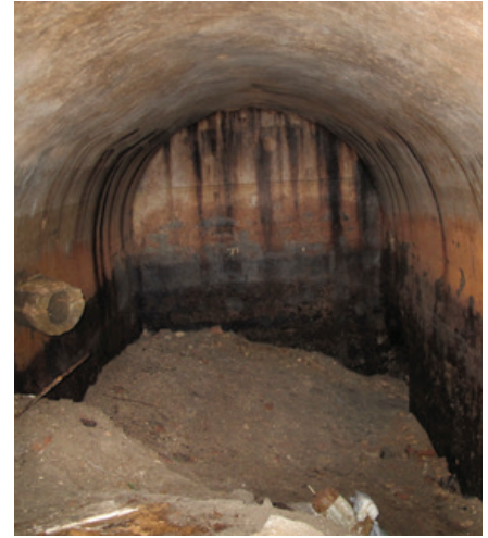
Şekil 27. Eski İmaret Camii Altındaki Sarnıç'ta taş besleme kanalının görünümü
