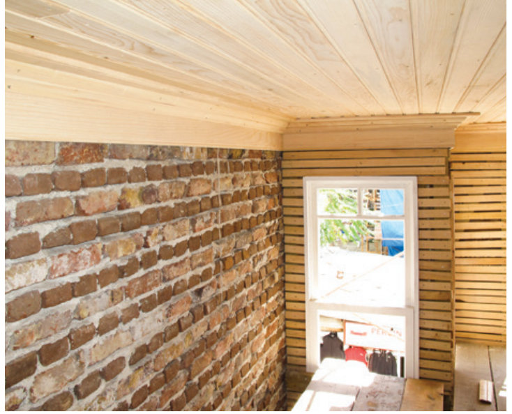
Şekil 20. Dönem eki yapıda tavan uygulaması.
