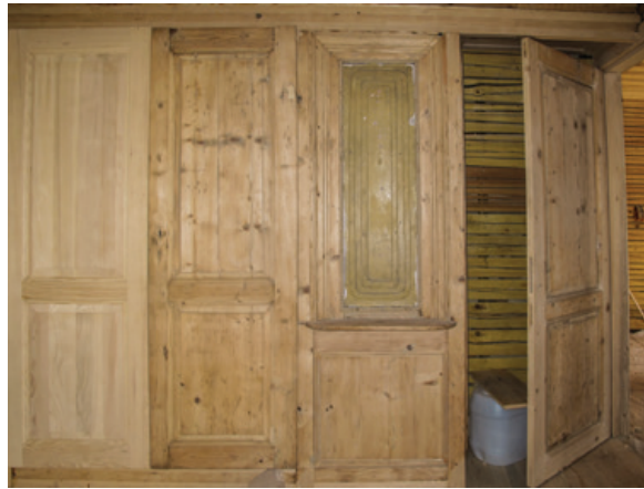
Şekil 42. Onarım sonrası yerine yerleştirilen yüklük.
