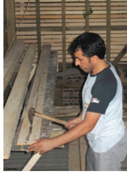
Şekil 4. Yarma bağıdadî duvar yapımı-çıtaların yarılması ve çakılması.
