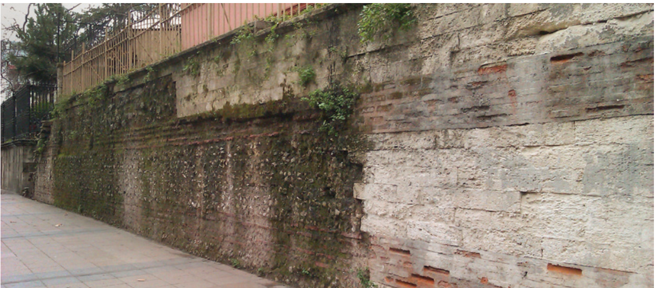
Şekil 2. Çağaloğlu Sarnıcı'nın doğu duvarına ait kalıntı.
