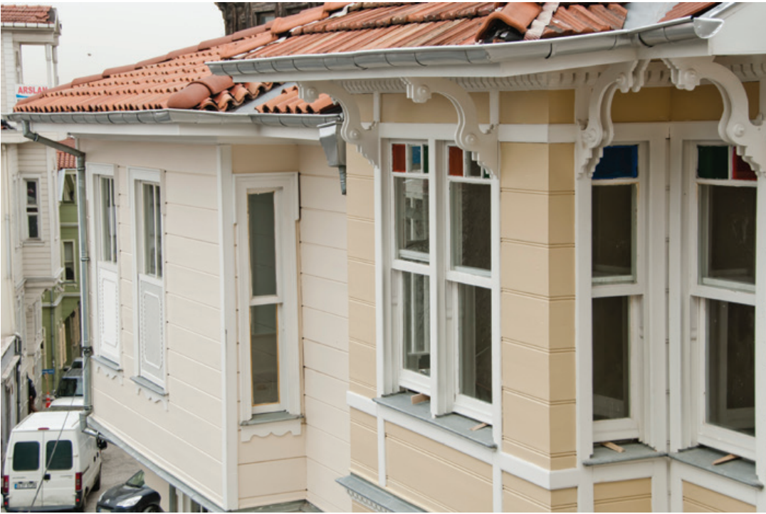
Şekil 47. Dış cephede boya uygulaması.
