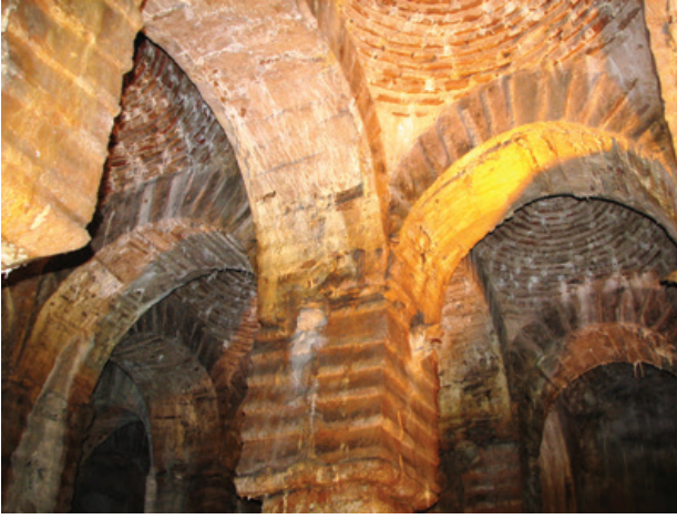
Şekil 20. Yavuz Sultan Selim Camii Avlu Yanındaki I no.lu Sarnıç (Sav, 2010) ve Vidinli Tefik Paşa Caddesi Sarnıcı'nda kemer uygulamaları.
