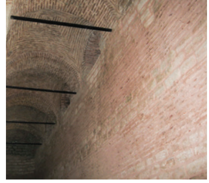
Şekil 9. İbadethane Sokağı I no.lu Sarnıç, Antik Otel Sarnıcı ve Sultan Sarnıcı'nda duvar örgü sistemi detay görüntüleri.
