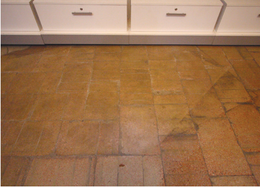
Yakın dönemde dökme mozaik tekniği ile yapılmış muhdes zemin. döşeme
