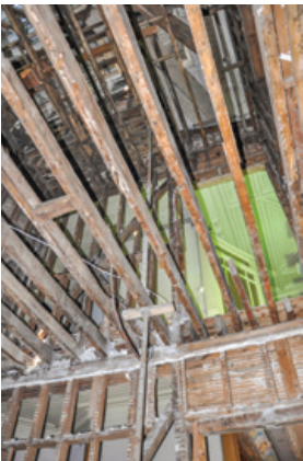
i. Taşıyıcı ahşap elemanlarda yenileme çalışmaları
