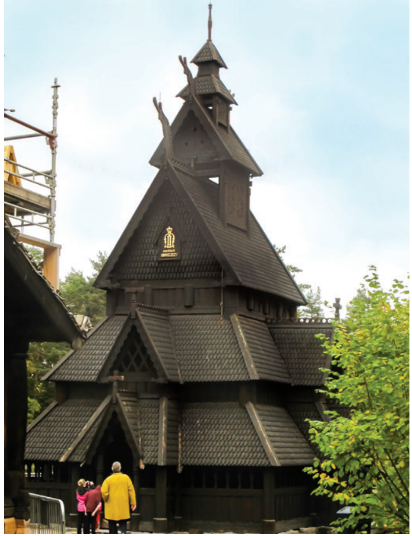
Ahşap dışında hiçbir malzeme kullanılmadan inşa edilen Gol Stave Kilisesi ( Gol Stavkirke )
