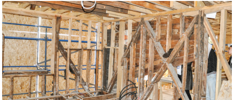
i. Taşıyıcı ahşap elemanlarda yenileme çalışmaları
