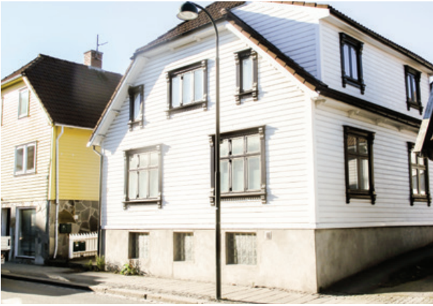
Stavanger, 3-4 katlı ahşap yapılar
