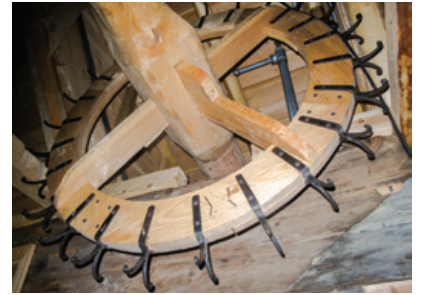
Çatı arasında bulunan özgün ahşap değirmen
