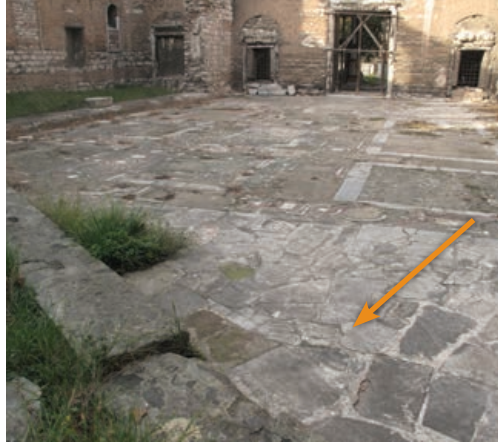
Şekil 19. Sekinin döndürülmesinden sonra yapılan döşeme
