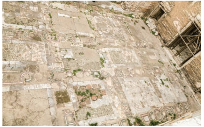
Şekil 4. Naos - orta nefin opus sectile döşemesi (Fotoğraf: Ahmet Mutlu, 2013)
