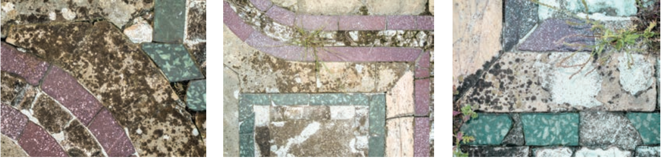
Şekil 55. Örgüdeki sarı mermer yüzeylerinde liken oluşumu
