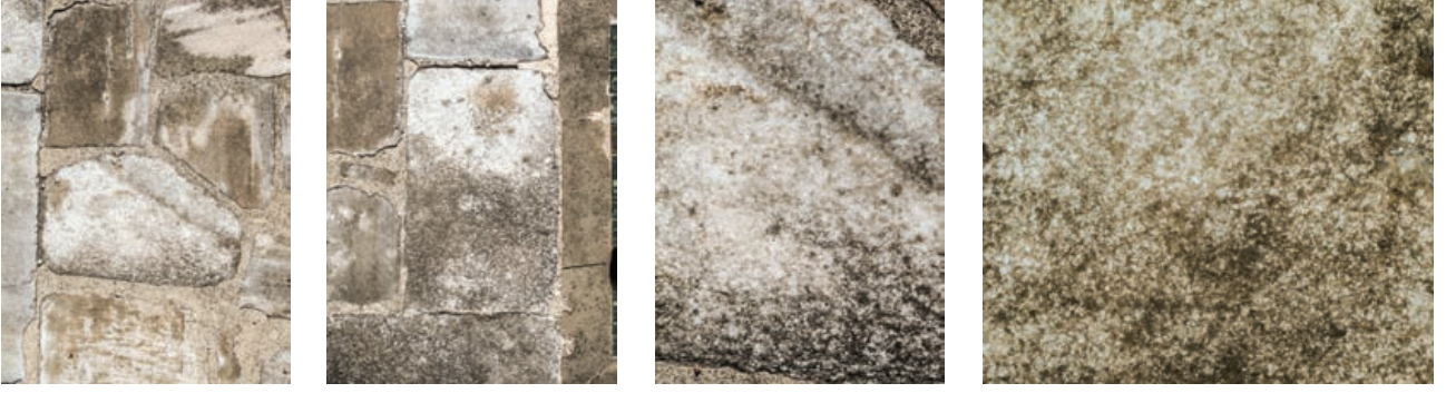
Şekil 53. Şekersî aşınma/şekerlenme örnekleri
