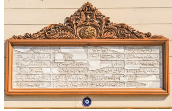
Şekil 34. Semahane giriş kapısı üzerindeki kitabe ve ahşap çerçevesi, restorasyon sonrası
