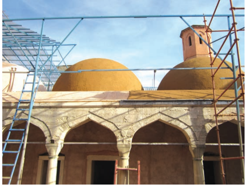
Şekil 2. Kubbe için hazırlanan çamur sıva ve kullanım sonrası genel görünüşü (İstanbul Atik Valide Camii Külliyesi)
