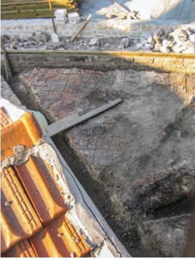
Şekil 8. Şerbethane temel kalıntısı
