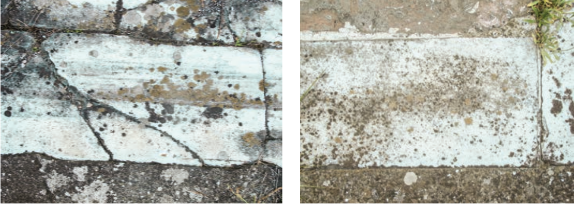
Şekil 54. Beyaz mermer yüzeylerinde liken oluşumu
