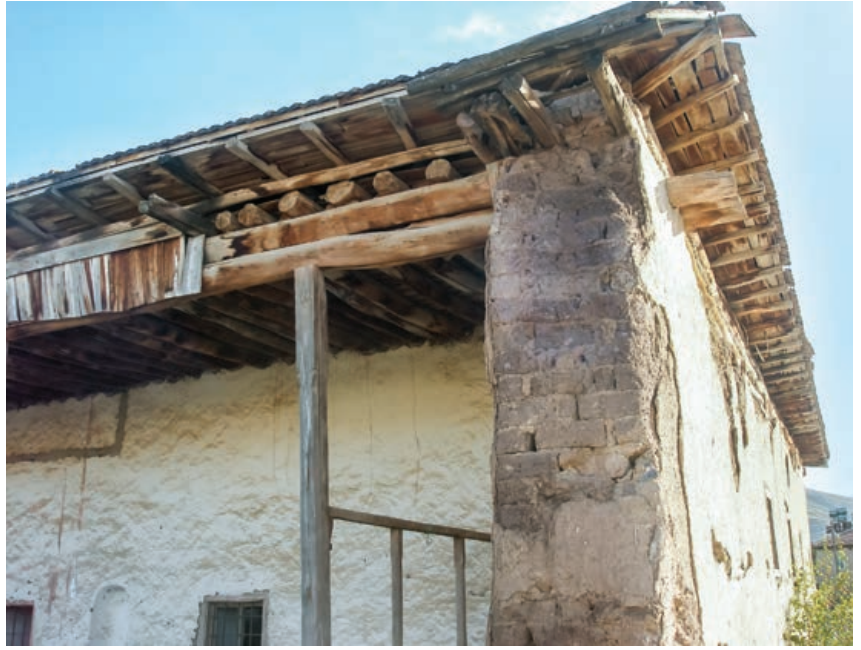
Şekil 3. Malatya’da halen kullanılmakta olan bir kerpîç evden detay.
