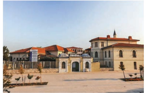
Şekil 39. Mevlevihane, restorasyon sonrası
