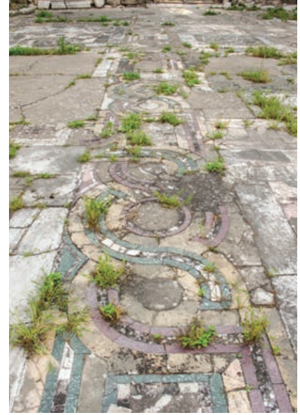
Şekil 59. Döşemenin genel durumu
