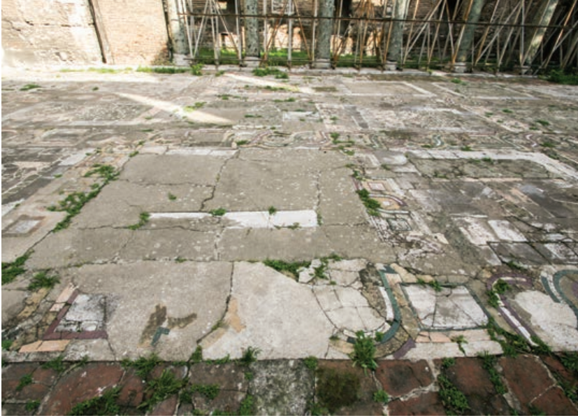
Şekil 58. Çimentolu harçla yapılan dolgu
