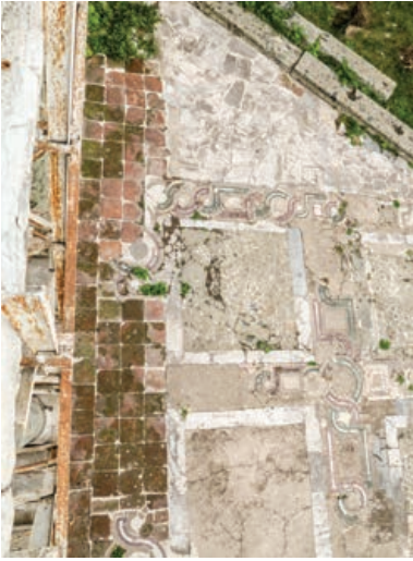
Şekil 16. Opus sectile 'nin kuzeyindeki tuğla dolgu (Fotoğraf: Ahmet Mutlu, 2013)
