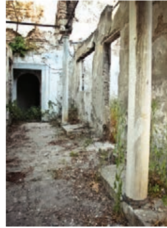
Şekil 14. Birinci kat girişinde yer alan mermer sütunlar, sekili mekân ve bu mekân içerisindeki muhdes duvarlar
