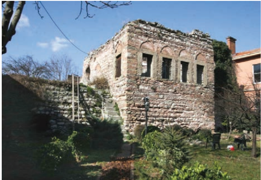
Şekil 2. Yapının güneydoğu cephesi
