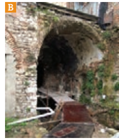
Şekil 11. Zeyrek Camii, hünkâr kasrının altyapısını oluşturan tonozlar, A. doğudan birinci tonoz içinde civit kalıntısı (2003), B. Aynı tonoz (2012), C. Batıdan birinci tonoz ve üzerindeki uygunsuz ekler (2012)
