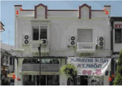
Sekil 7. Kontrol noktalarının yüzey üzerindeki dağılımı
