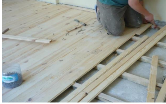
Şekil 4. Tahta yer döşemesi uygulaması (URL6, 2016)
