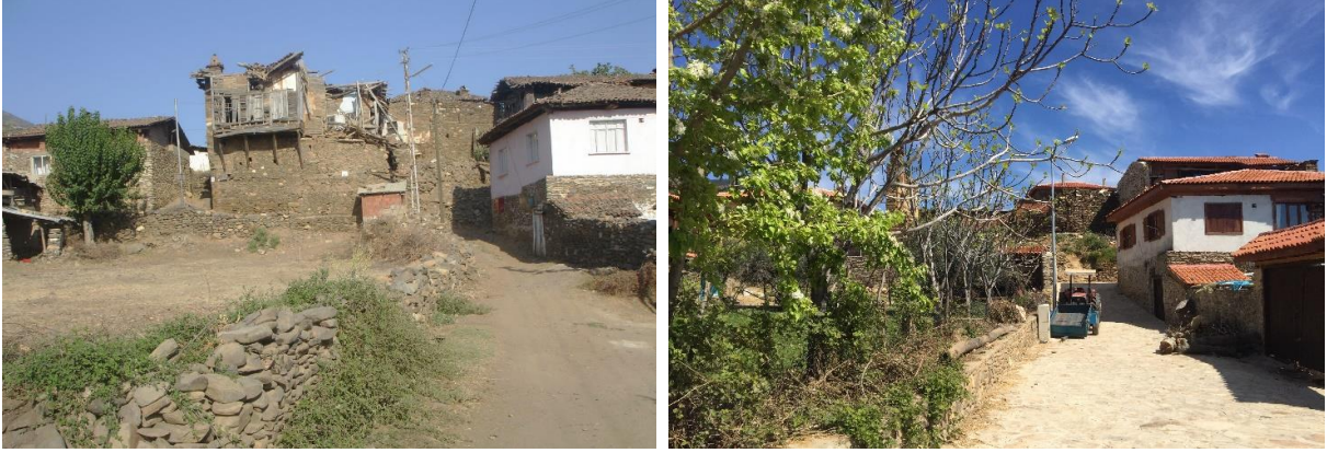
Şekil 3. Birgi Taşpazar mevki sokak sağlıklaştırma çalışmaları öncesi ve sonrası.
