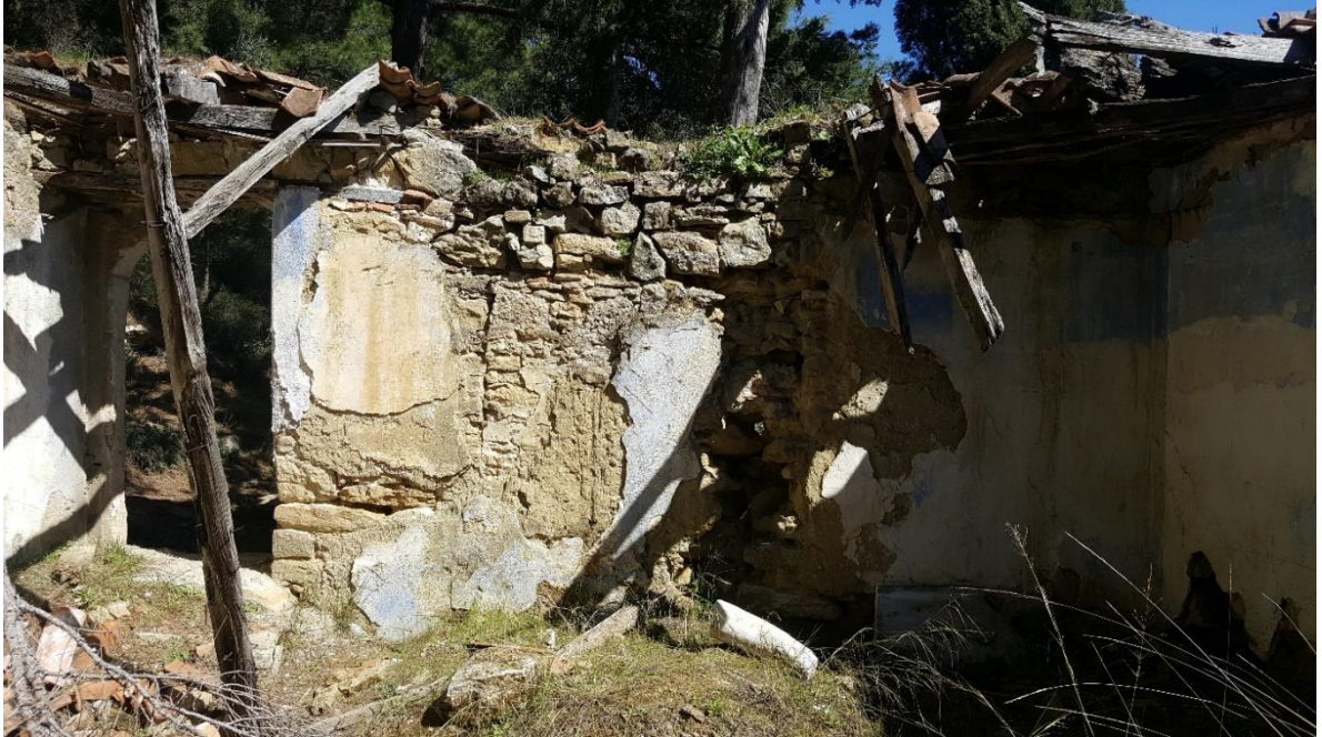
Türbe yapısının iç doğu duvarı. Bu duvarda olduğu bahsedilen dolap yapısı, tahribat nedeniyle net olarak seçilememektedir.
