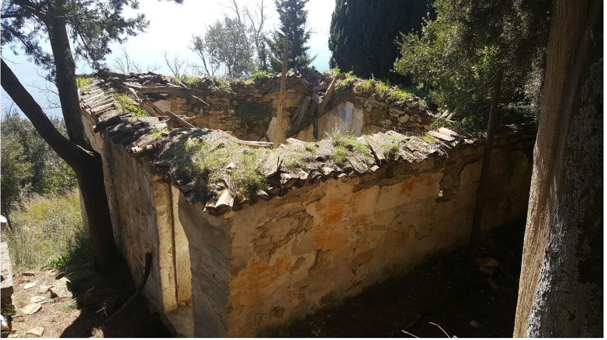
Türbe yapısının yukarıdan görünüşü ve doğu tarafından giriş kapısı ile çatısında mevcut kalan kiremitler. Arka planda Çanakkale Boğazı manzarası.
