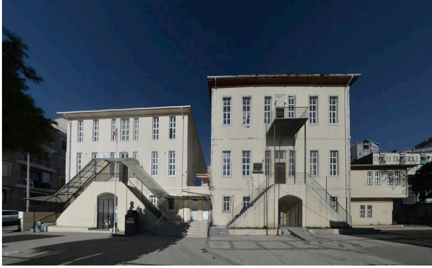
Ek-4: Binaların günümüzdeki durumu. İstiklal İlköğretim Okulu Yerleşkesi
