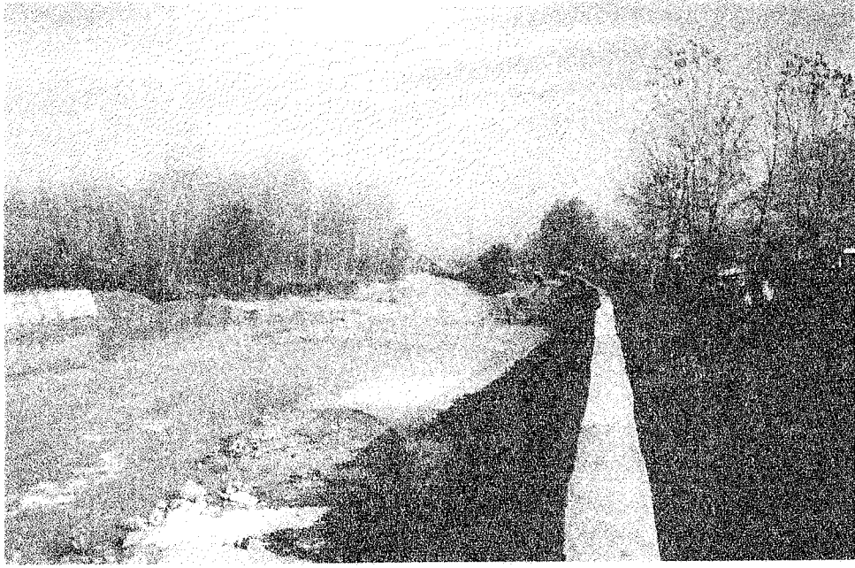
Foto- 1 : Taşköprü yakınlarında Gökırmak yatağı boyunca yapılan taşkın önleme duvarı.
