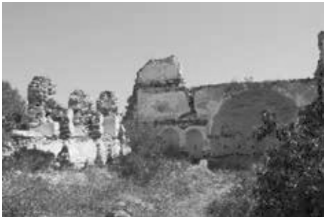
Res.9: Kilise, içten görünüş.
