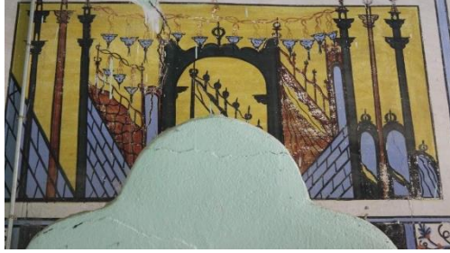
Resim-16: Kışlak Eski Camii Kible Duvarı Süsleme Detayı.
