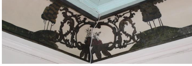
Resim-15: Hacı Mehmed Ağa Camii Harim Kuzeydoğu Köşesi Süsleme Detayı.
