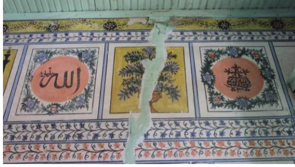
Resim-14: Kışlak Eski Camii Kible Duvarı Süsleme Detayı.
