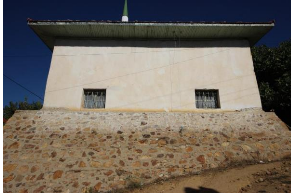
Resim-2: Kışlak Eski Camii Güney Cephesi Görünümü.
