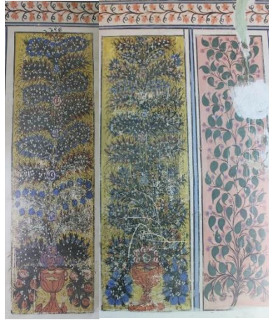
Resim-18: Kışlak Eski Camii Kible Duvarı Süsleme Detayı.
