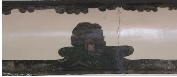
Resim-17: Hacı Mehmed Ağa Camii Doğu Duvarı Süsleme Detayı.
