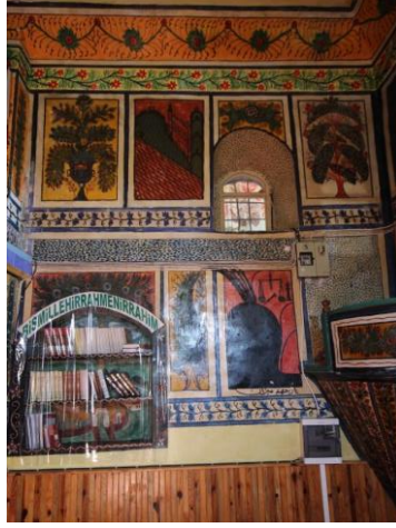
Resim-31: Ahatlar Camii Doğu Duvarı.
