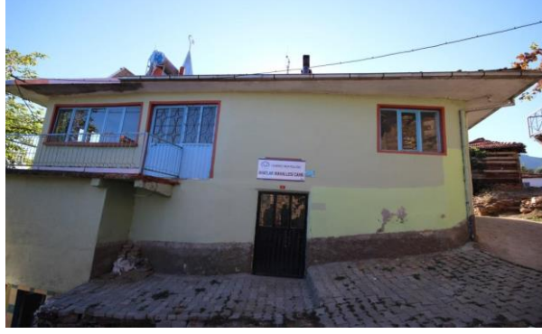
Resim-25: Ahatlar Camii Doğu Cephesi Görünümü.
