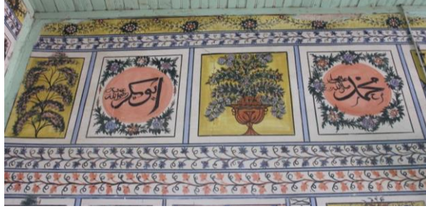
Resim-13: Kışlak Eski Camii Kible Duvarı Süsleme Detayı.
