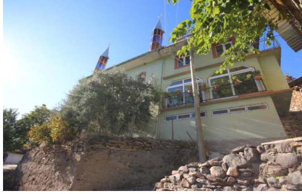
Resim-29: Ahatlar Camii Güney Cephesi Görünümü.
