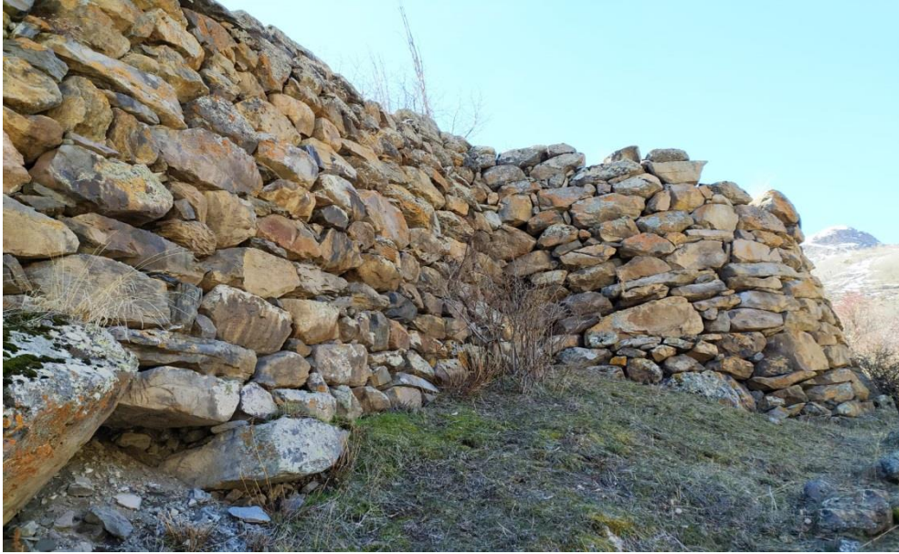
Fotoğraf 9. Uzunkavak Kalesi Kiklopik Teknikte Yapılmış Sur Duvarları
