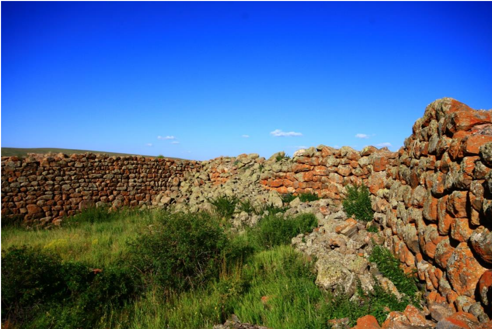
Fotoğraf 2. Kapıkaya Kalesi I Kiklopik Teknikte Yapılmış Sur Duvarları
