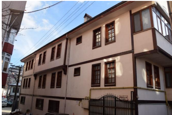
Foto 7. Kırıkoğlu Apartmanı, arka cephesi
