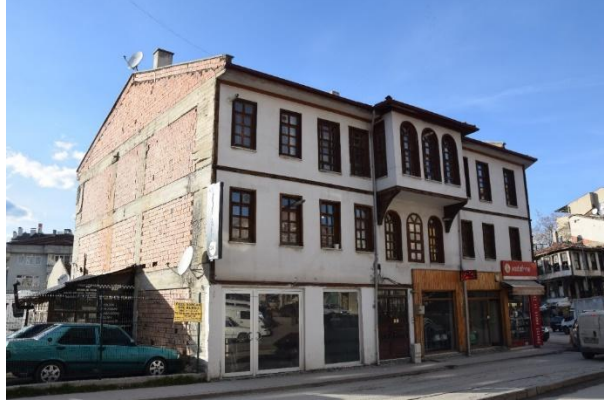
Foto 5. Keskin Apartmanı, tuğla ile örülen yan cephe detayı
