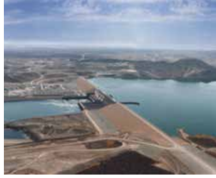
Birecik Barajı (2000) Kurulu Güç: 672 MW Enerji Üretimi: 2516 GWh/yıl
