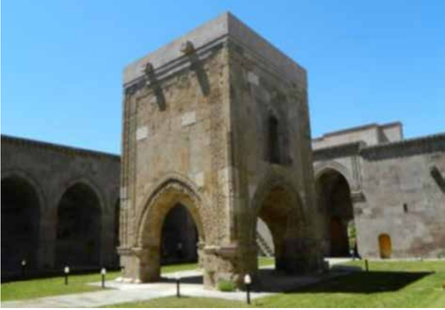
Resim 3 a: Kayseri Sultanhan avlusunda dört ayaklı köşk mescit . ( http://www.geolocation.ws/v/P/92704626/kayseri-sultanhan-kervansaray-avlu-ve/en )
