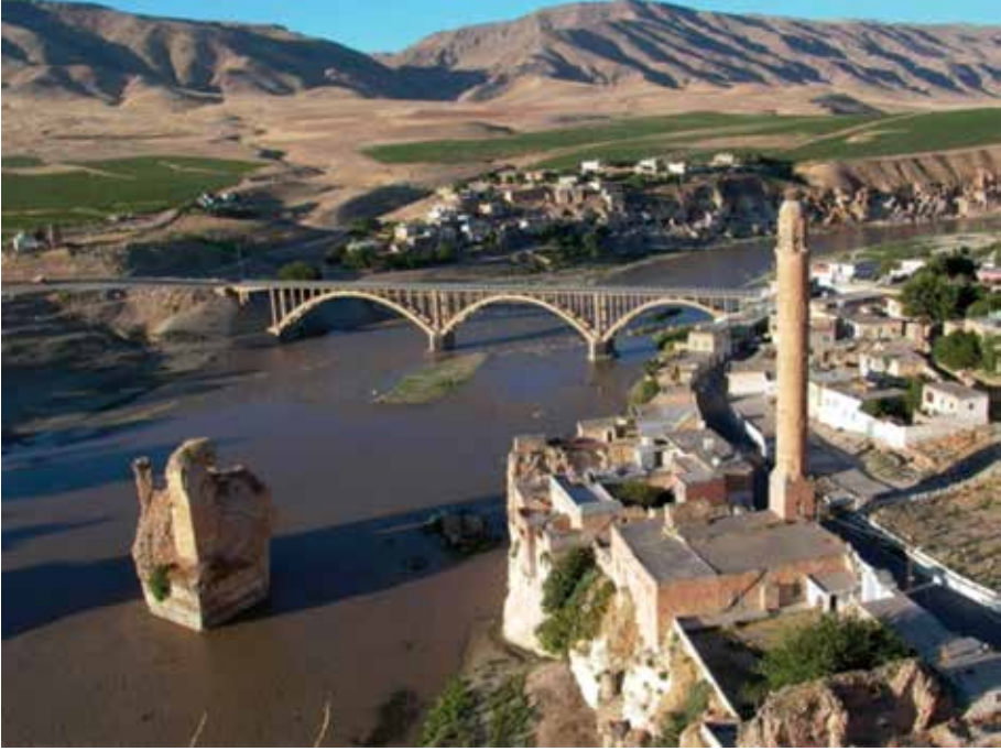
Ilisu Barajı (Dicle) (yapım aşamasında) Hasankeyf'i yok edecek
