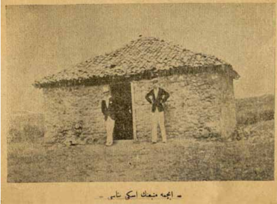
İçme Menbaanın Eski Binası.
