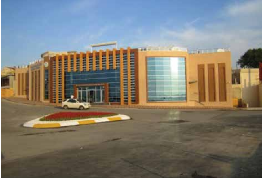
Tuzla Belediyesi Nikâh Sarayı ve Kültür Merkezi
