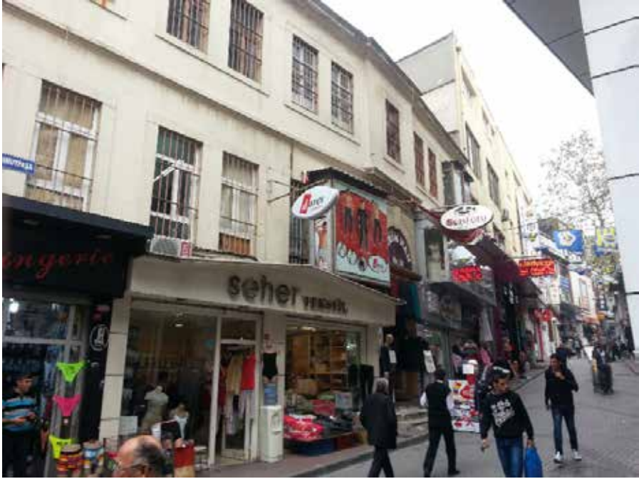
Şekil 9. Bezciler Sokak Cephesi (Öztekin, 2016).
