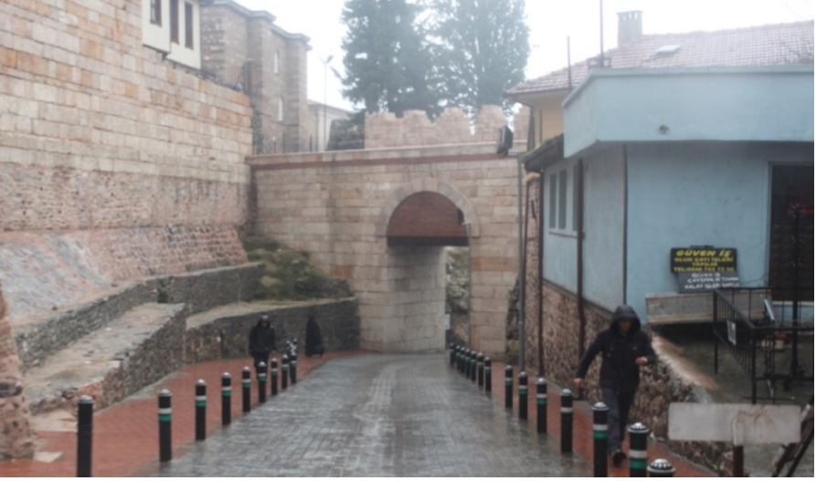
Resim 1: Taht-ı Kale Kapısı iç yüz görünümü
