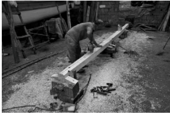
Fotoğraf-14: Omurganın yapımı (Bartın İli Kurucaşile İlçesi Kapısıyü Köyü)
