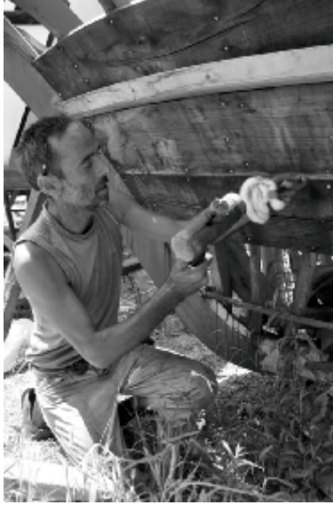
Fotoğraf-16: Kalafat işlemi (Ordu İli Perşembe İlçesi Kışlaönü)
