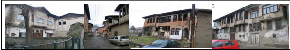
Şekil 3. Çalışma alanında bulunan bakımsız evler
