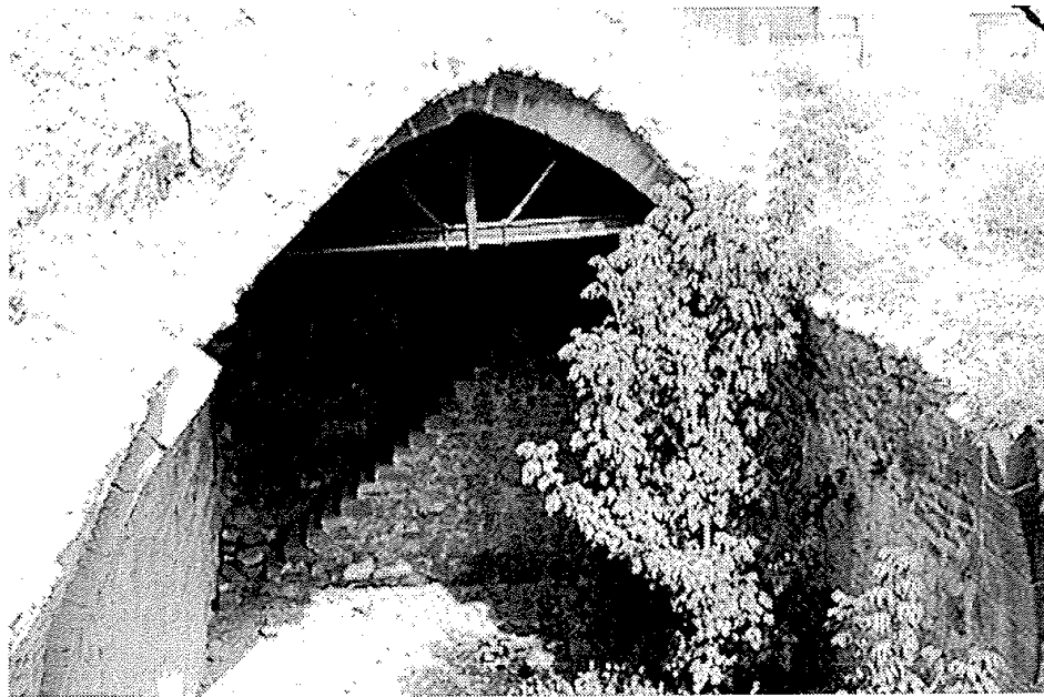
Res.4- Buzhane yıkıldıktan sonra.
