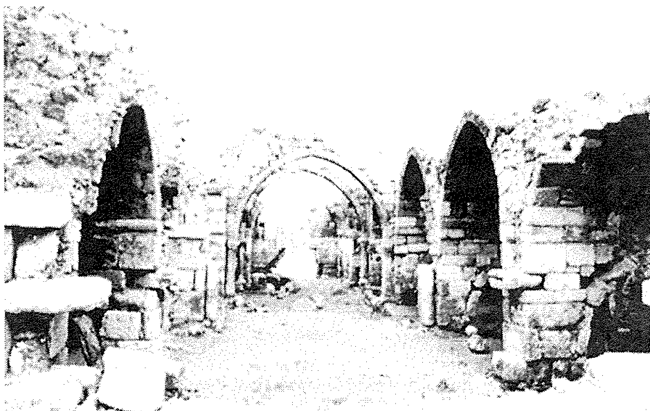
Res.16- Obruk Hanı, kapalı bölüm temizlendikten sonra.
