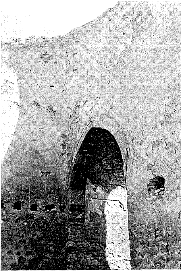
Res.3-Aksaray-Melik Mahmud Gazi Hangâhı, ana mekan kubbe geçişi ve küçük eyvan kemerinin görünüşü.
