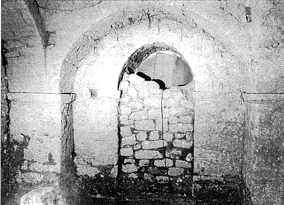
Res.4- Kubbeli yapı, içten kuzeye bakış.
