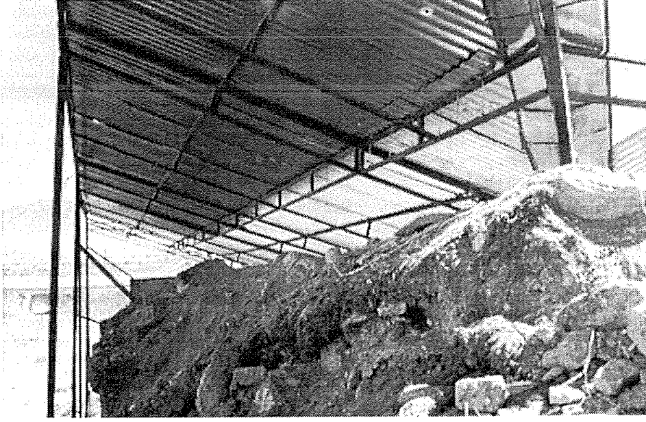
Res.15- Profil iskelete kaplanan galvaniz, oluklu saçlar.
