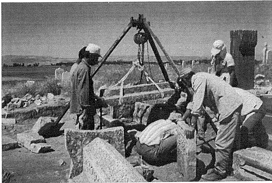
Res.4- Selçuklu Mezarlığı'nda restorasyon çalışmaları.
