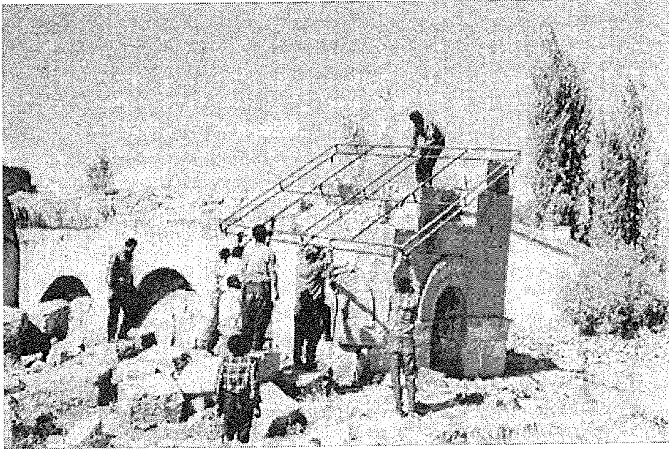
Res.12- Profillerin yerleştirilmesi.
