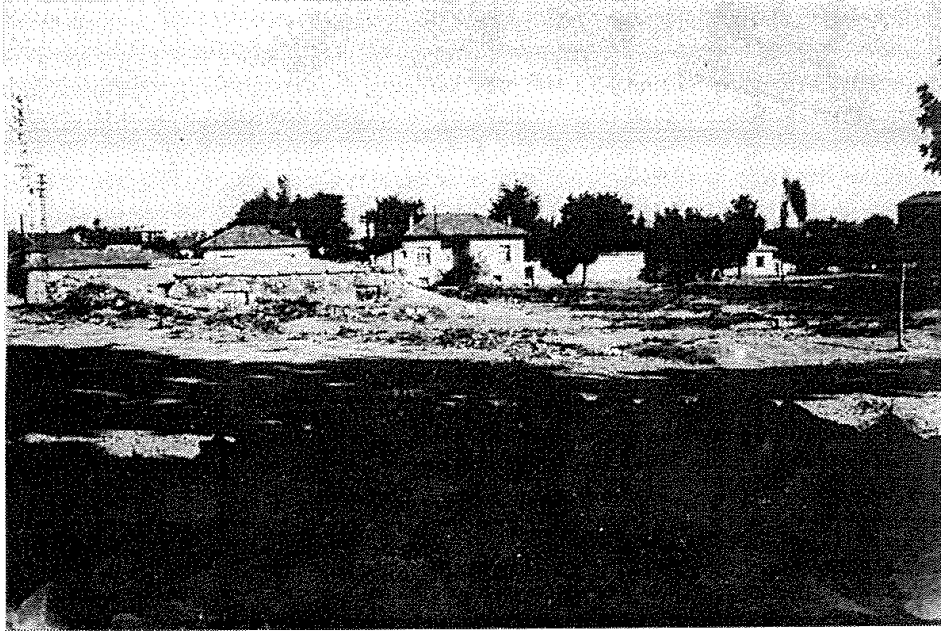
Res.3- Buzhane'nin yıkılmadan önceki hali.
