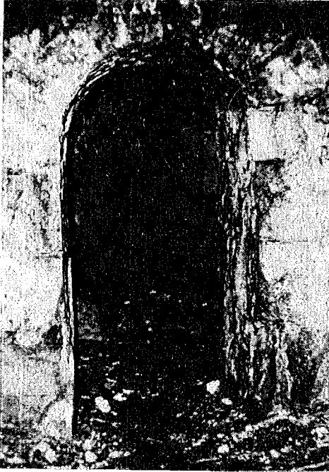
Resim 12.- Eskipazar Büyük Hamam. Kapı Açıklığı
