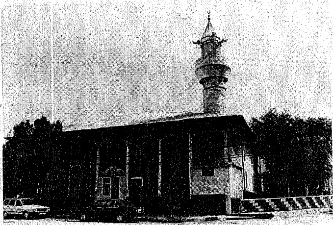
Resim 1 - Caminin Giriş Cephesinden Genel Görünüşü
