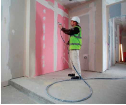
Görsel 1: Alçıpan üzeri püskürtme alçı sıva (solda) ve saten alçı (sağda) uygulaması (http1,13).
