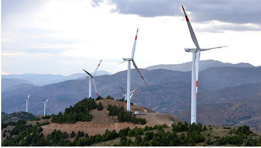
Şekil 8. Adıyaman Sincik rüzgâr enerji santrali
