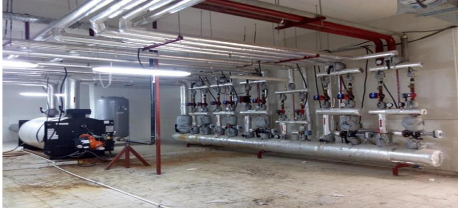
Şekil 1.iki geçişli kazan.
