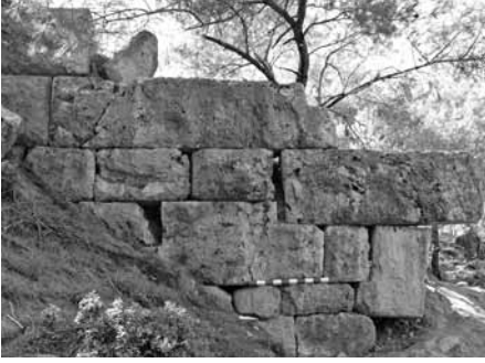
Res. 5 Balıcaoluk, doğu sur duvarı, doğu dış cephe
