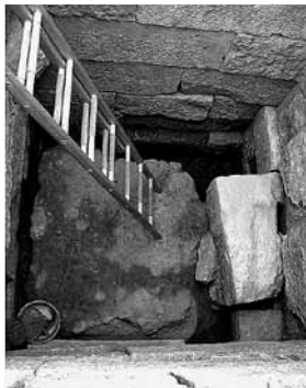
Abb. 14 Blick in einen „Caisson“ des Rasterfundaments (Nord- Pteron, vgl. Abb. 1, Nr.11)
