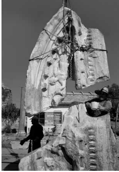
Res. 20 Sceanae Frons Parçalarının Onarımı
