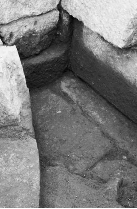
Res. 16 Kuzey Stoa, Güney Batı Köşesi, Ana Kaya Üzerine Oturan Temel
