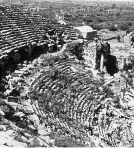
Res. 13 Diazoma Onarım Öncesi (1971)
