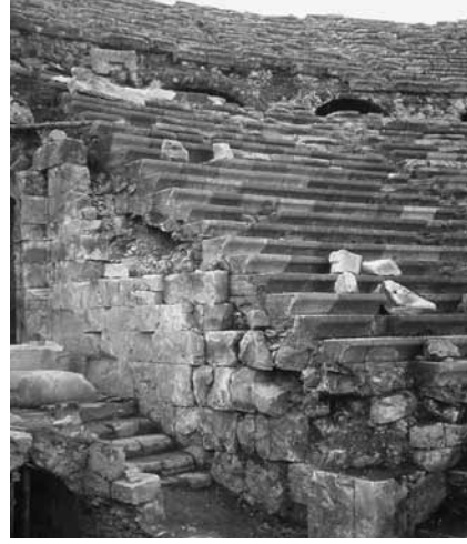
Res. 15 Analemma Duvarında Bozulmalar
