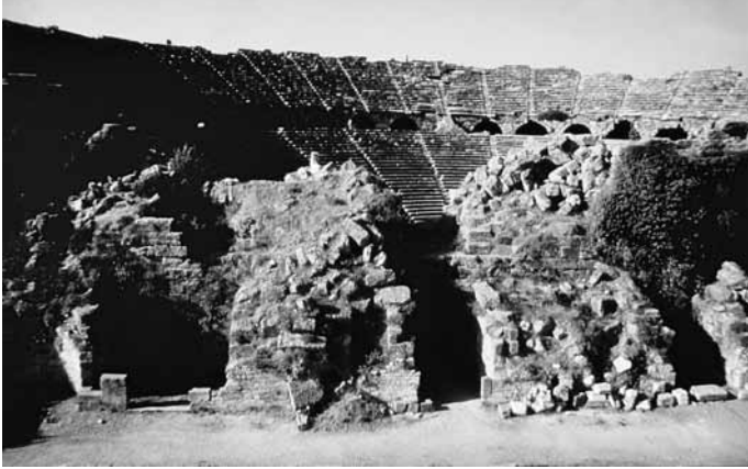
Res. 24 Sahne Binası Arka Cephesi Onarım Öncesi
