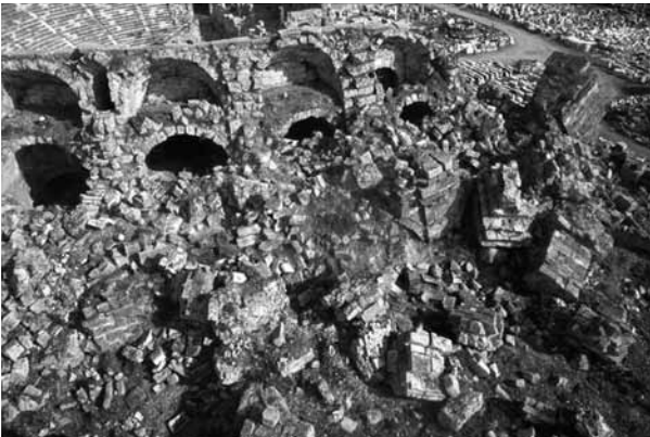
Res. 16 Dış Galerideki Deprem Yıkıntıları
