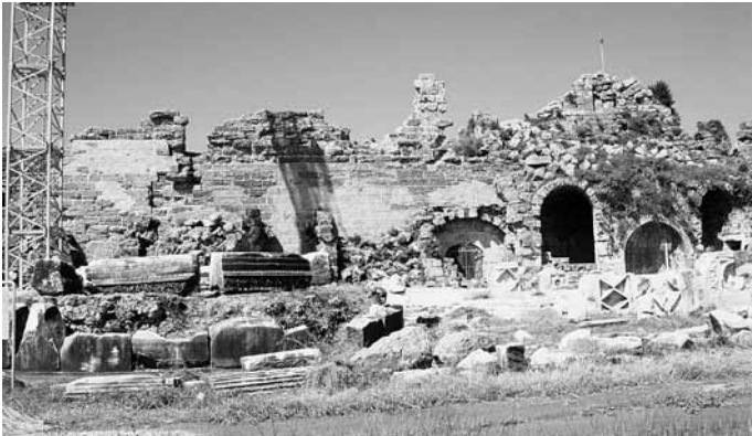
Res. 25 Onarım Sonrası
