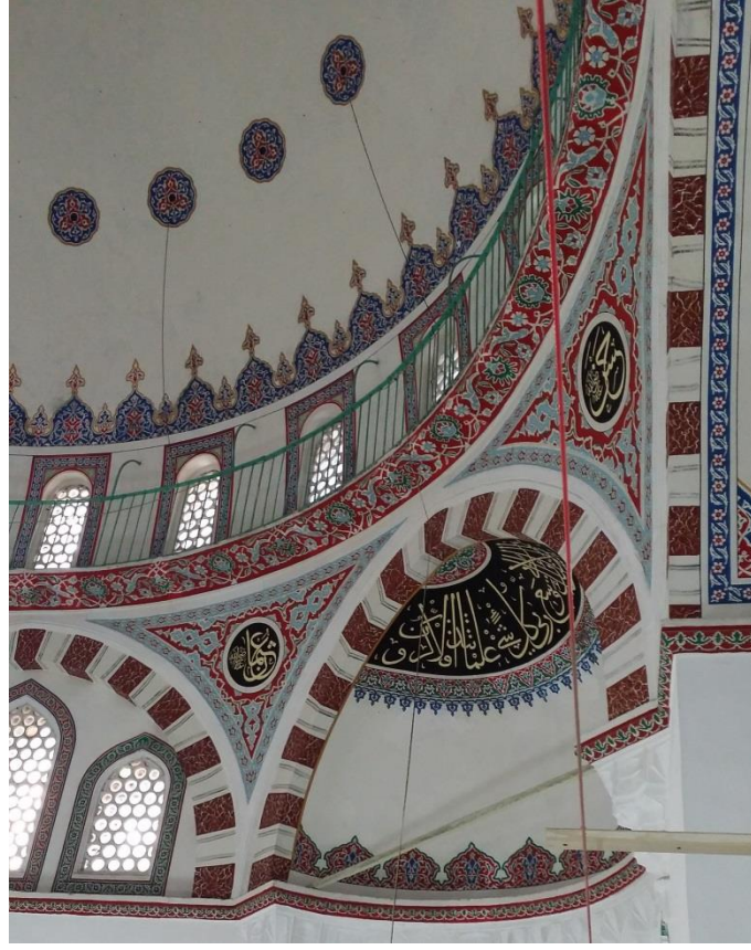
Fotoğraf 11: Pertev Paşa Camii kubbe geçiş elemanları
