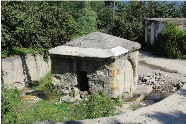
Resim 3- Beşoluk Çeşmesi'nin Güneydoğudan Görünüş
