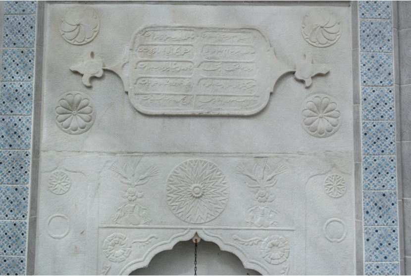
Res.46- Dede Çeşmesi, cepheden ayrıntı
