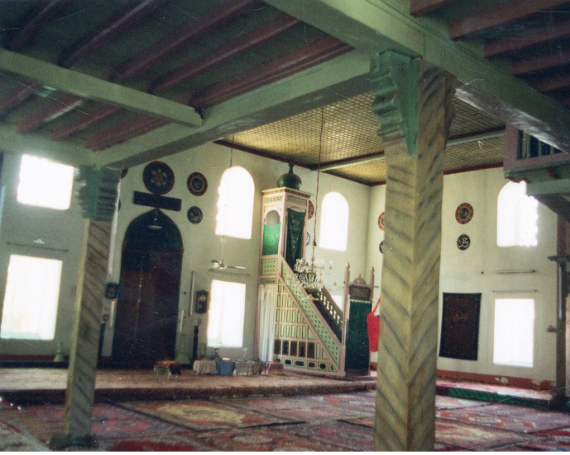
Res.21- Onarımdan önce mihrap ve minber
