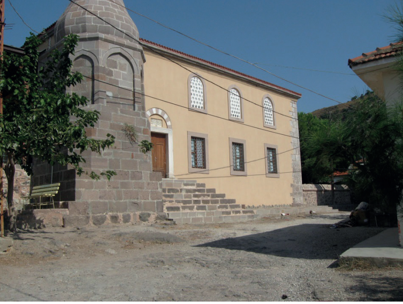
Res.15- Batı cephe, onarım sonrası
