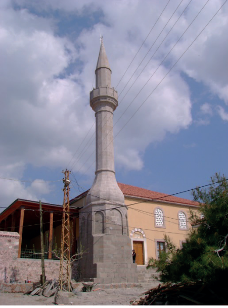
Res.17- Minare, onarım sonrası
