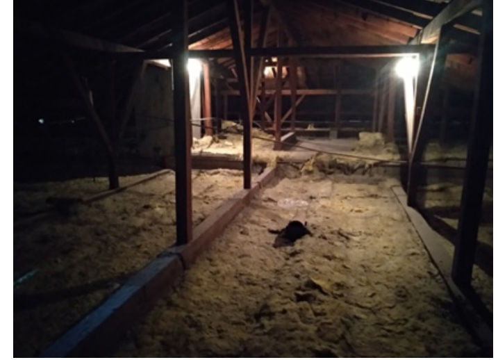
Görsel 12. Çatı izolasyonu (ÇMM, 2021)
