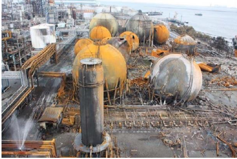
Şekil 1: Deprem ve yangından hasar görmüş küresel tanklar (Zama ve diğ. 2012)
