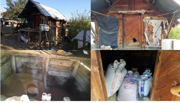
Şekil 4. Elmalı Bayındır Mahallesi Muttalip Demir Ailesine Ait Tahıl Ambarı (80 Yıllık)
