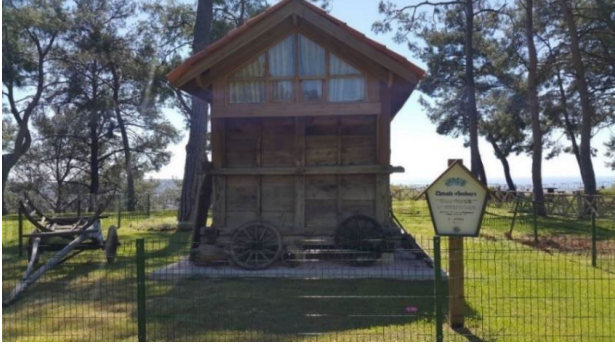
Şekil 22. Antalya Kepez İlçesi Kent Ormanında Bulunan Elmalı Tahıl ambarı
