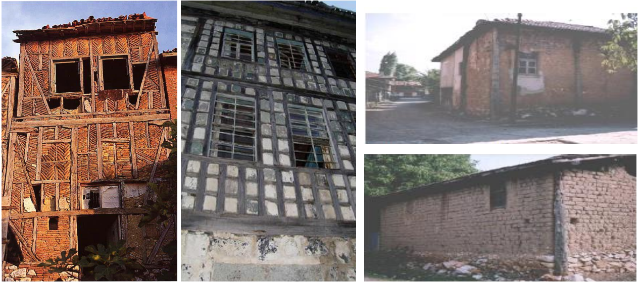
Şekil 2.15. (a) Hımış (b) Göz dolma yapılar (Arun, 2005). (c) Ahşap dikmelerle desteklenmiş kerpiç yapılar (Koçu, Korkmaz, 2004).
