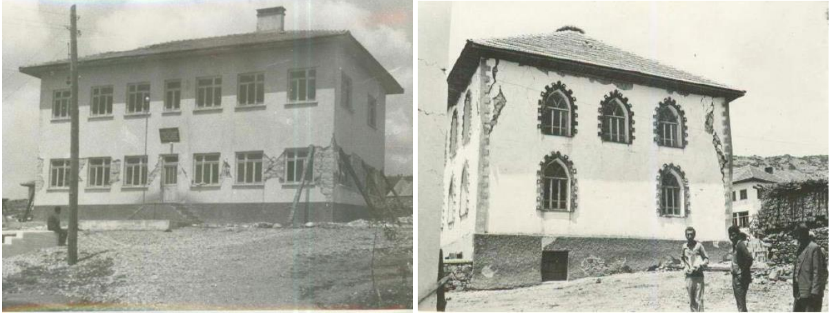
Şekil 2.18. (a) Rijit Kat Döşemeli Yığma Yapıda Deprem Hasarı (b) Esnek kat döşemeli Yığma Yapıda Deprem Hasarı (1970 Gediz depremi) (Bayülke, 2011)
