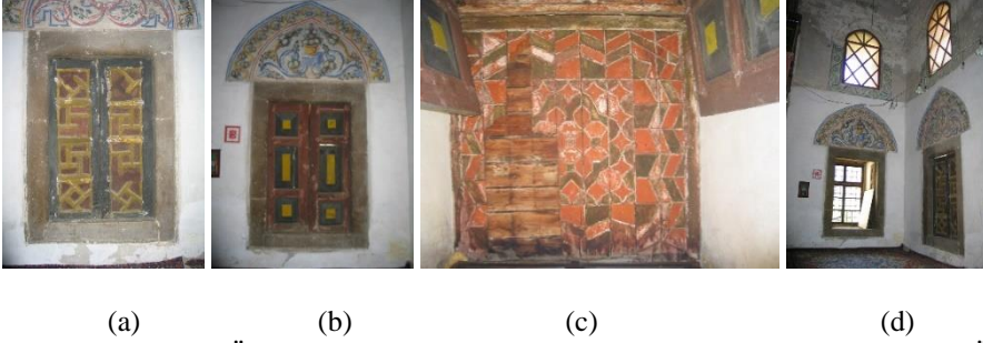
Resim 9. a ve b. Özgün pencere kapağı, c. Pencere tavanı ahşap süsleme, d. Üst pencere ahşap pencere doğramaları (Sevgi, 2006)
