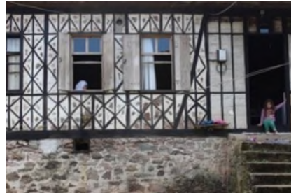
Şekil 2. Ahşap İskelet Sistem (Çağlıcı, 2018)
