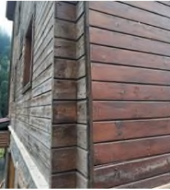
Şekil 1. Yığma Sistem Duvar (Şahin, 2018)
