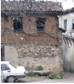
Şekil 5. Bursa Ahşap Ev (Şahin, 2012)
