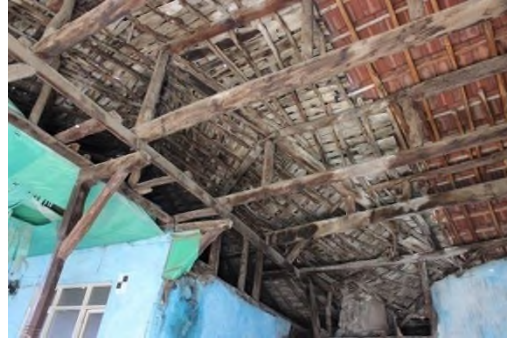
Şekil 75. Ahşap Çatı Sistemi (Çorum Bel. Etüt Prj. Müd. Arşivi, 2015; Mimor, 2015)
