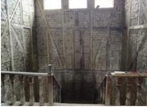
Şekil 20. Duvar Sistemi (Şahin, 2015)
