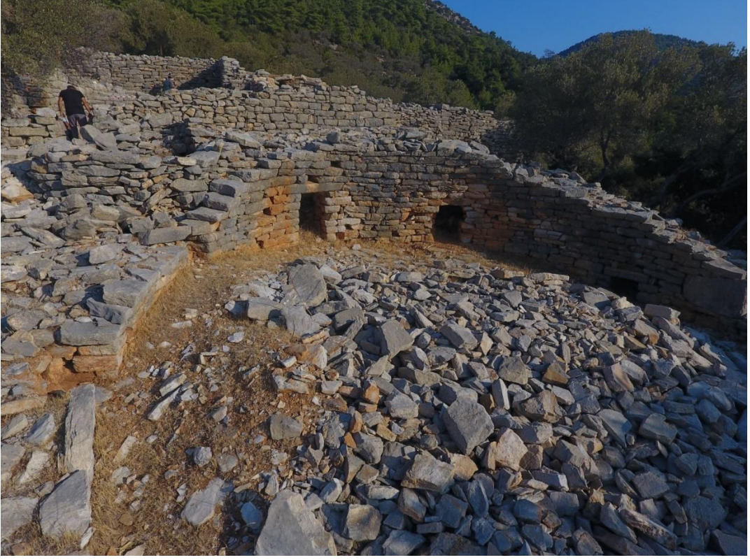
Resim 47: Compound dairesel avlu ve etrafındaki yařama mekânları
