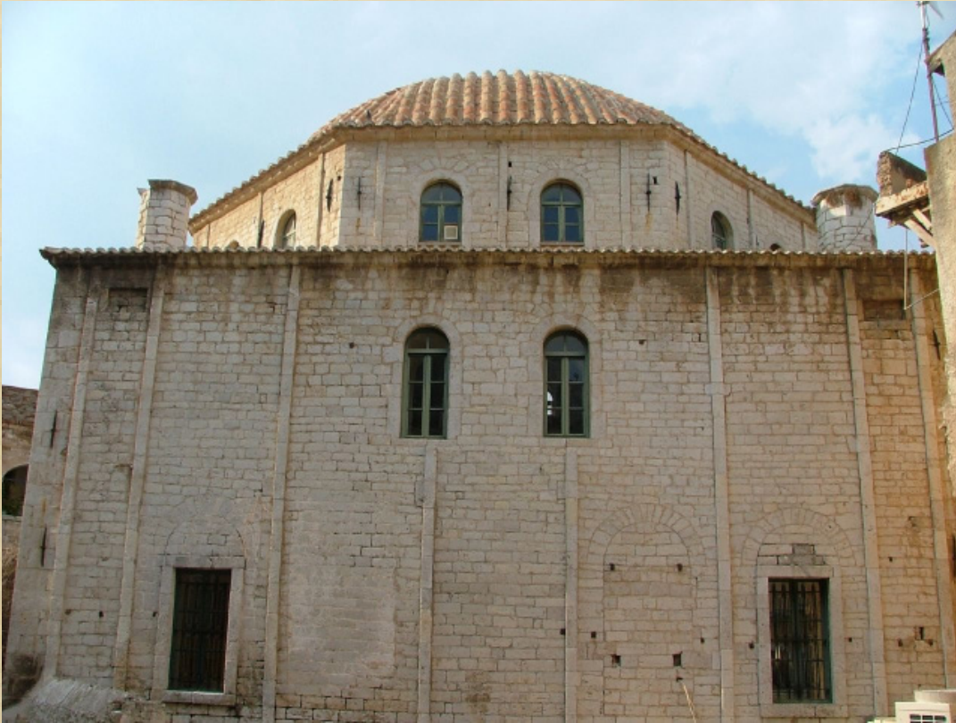
Resim-10 Anabolu (Nafplion) Ağa Caminin batı cephesi (Foto. Neval Konuk Halaçoğlu)
