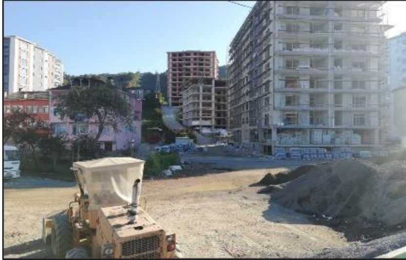
Şekil 5. Fındıklı’da Öğrencilerin Sık Kullandığı Yol Üzerindeki İnşaatlar
