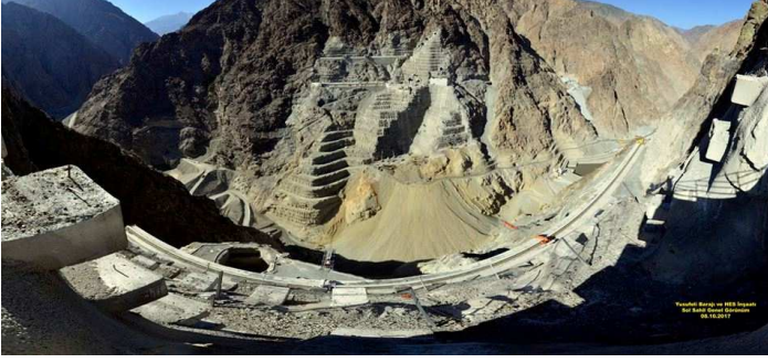
Şekil 8. Yusufeli Barajı (inşaat hali)
