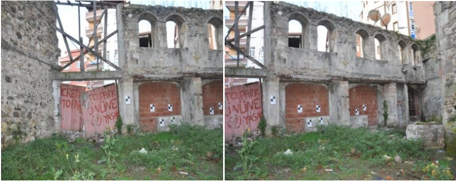
Foto No 5 ve 6: Kefeli Han kuzeybatı cephesi vitrinler ve kuzeybatı cephesi iç mekân görüntüsü
