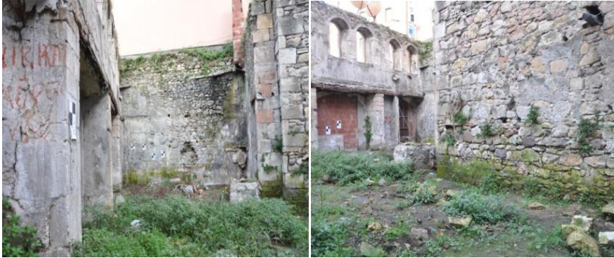
Foto No 7 ve 8: Kefeli Han kuzeydoğu cephesi iç mekân görüntüsü ve kuzeydoğu cephesi genel görüntüsü
