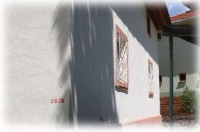
Fot. 7 Yapının güney cephesinden görünüm
