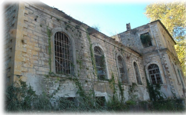
Fotoęraf 5: Kuzeybatı cephe
