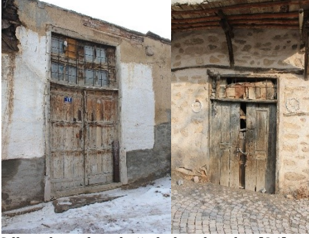
Şekil 5. Sille evlerinde sokağa bakan kapılar [26].
