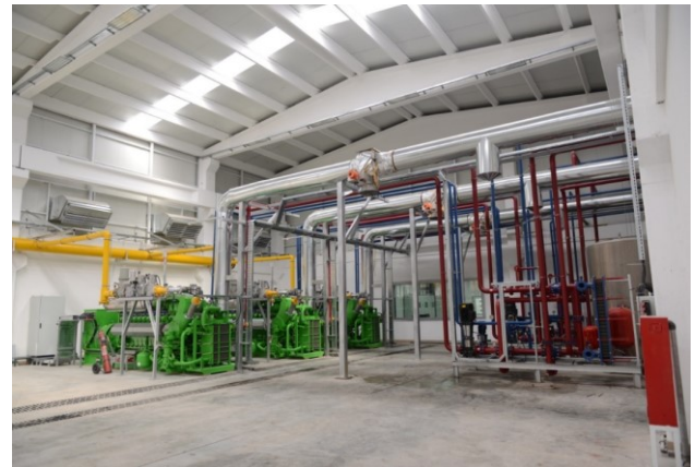
Şekil 2. Enerji Üretim Santrali Binası İç Görünümü
