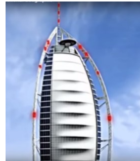
Şekil 3. Yapının Dış İskeletindeki Sönümleyiciler [26]
