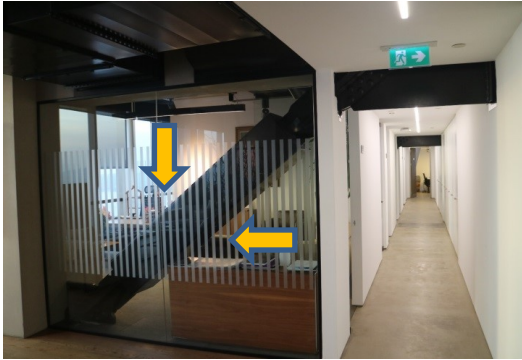
Şekil 16. Kule1 Outrigger Sönümlenme Sistemi [Yazar Arşivi]
