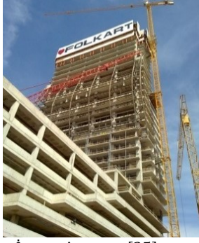
Şekil 13. Yapının İnşaat Aşaması [35]
