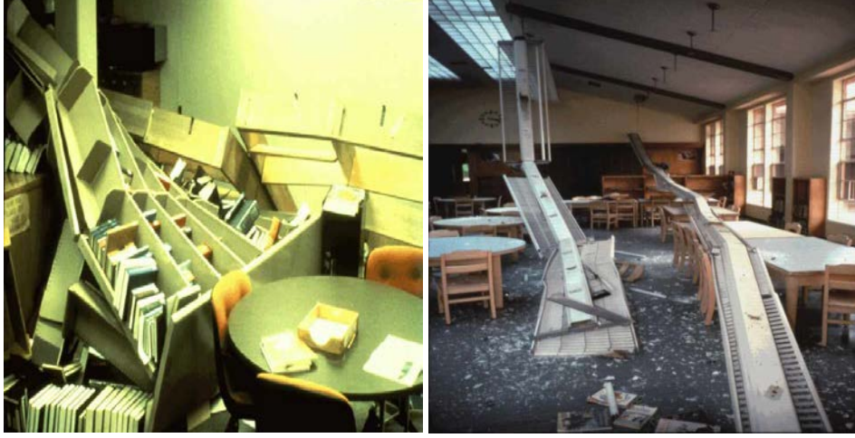
Resim 1: 1980 Livermore Depremi Lawrence Livermore Kütüphanesi'ndeki yapısal olmayan hasar ( Kaynak: USGS-IBHS,1999)-solda ve 1983 Coalinga Depremi Junior High School'daki yapısal olmayan hasar ( Kaynak: EERI, IBHS,1999)-sağda
