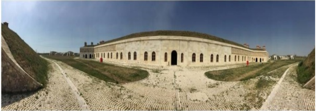
Görsel 12: Tabya'nın onarım öncesi ve sonrası genel görünümü II.
