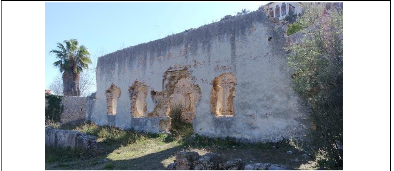
Fotoğraf 5: Mikhail Archangelos Kilisesi'nin genel görünüşü.
