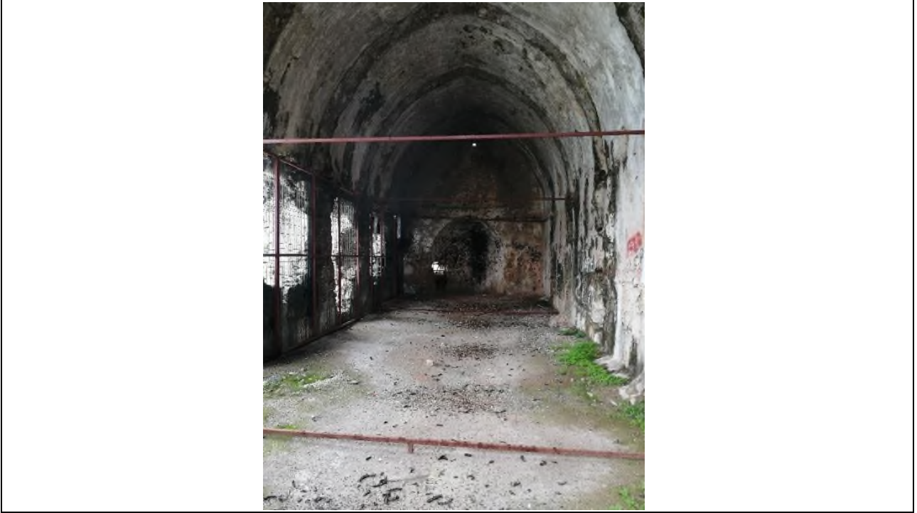
Fotoğraf 2: Naostan görünüşü (kuzeybatıya bakış).
