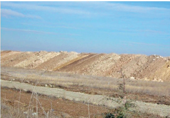
Şekil 9. Yol yapımı amacıyla yığılmış topraklar Figure 9. Superimposed soils for road building
