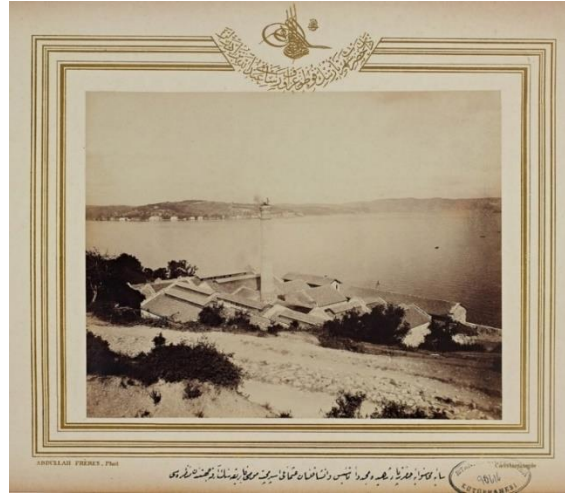
Foto. 2. Paşabahçe İspermeçet Fabrikasının arka taraftan görünüşü.
