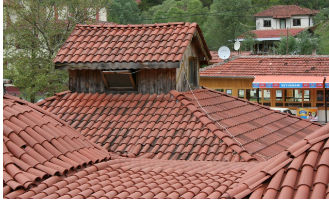
Şekil 35. Sey Hamamı Örtü sistemi, (Erkekler Soyunmalık Bölümü Aydınlık Açıklığı) (Kaynak: Yazarlara ait fotoğraf arşivi)
