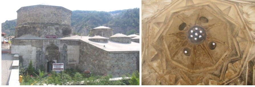
Şekil 12. Bolu Yıldırım Beyazıt Hamamı dış görünüş ve erkekler bölümü sıcaklık kubbesi (Kaynak: Yazarlara ait fotoğraf arşivi)
